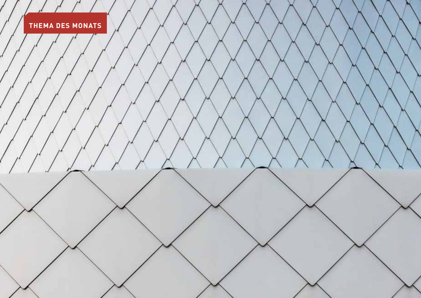
▲ Kunstwerk aus Aluminium: Die Rauten wurden teilweise über die Kanten der Gebäudehülle hinweg verlegt und bilden so eine fließende Fassade
