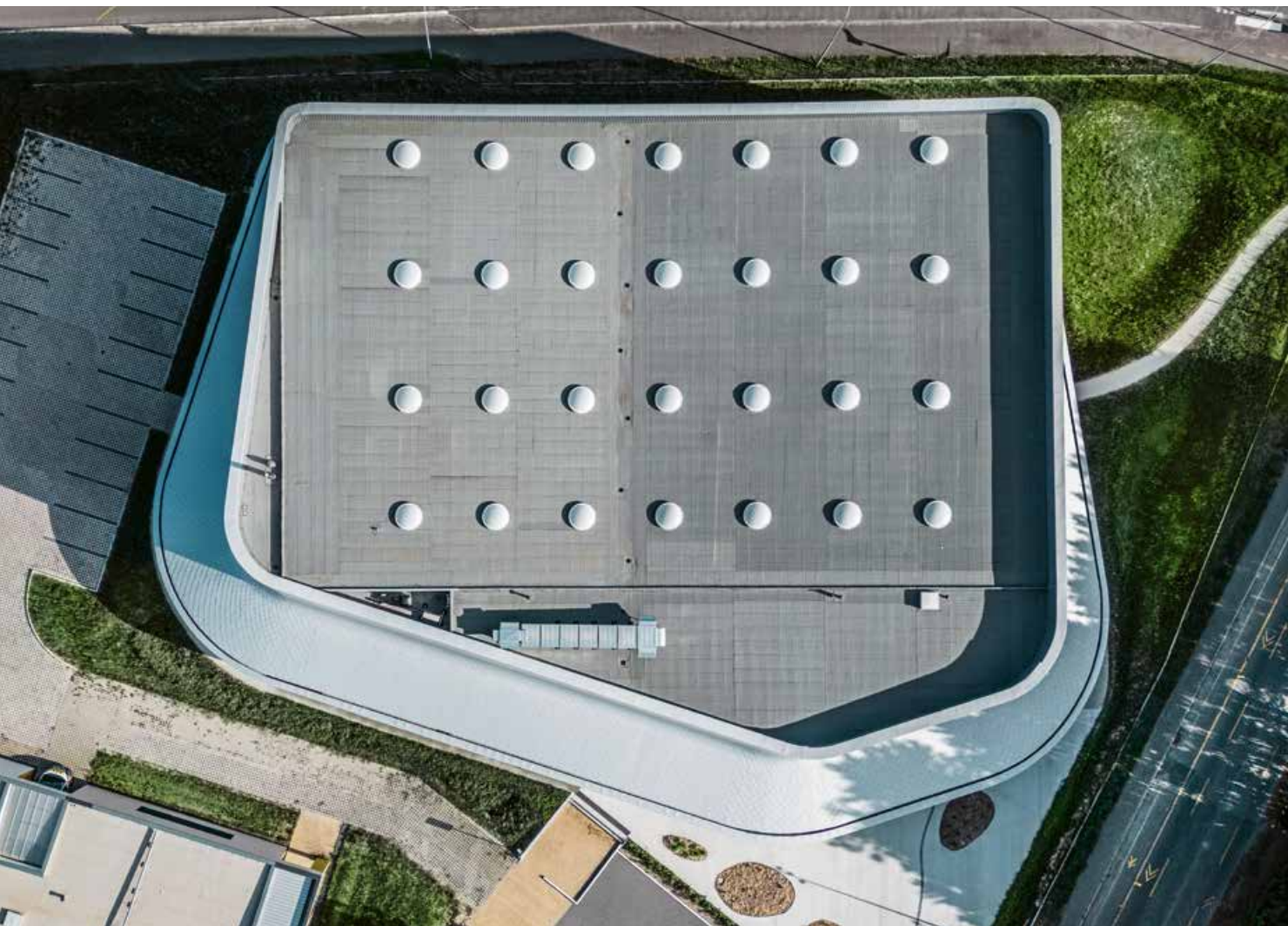
▼ Das unspektakuläre, regelmäßige Rechteck der Sporthalle bekommt hier eine mäandernde zweite Raumschicht, deren Ecken abgerundet sind
