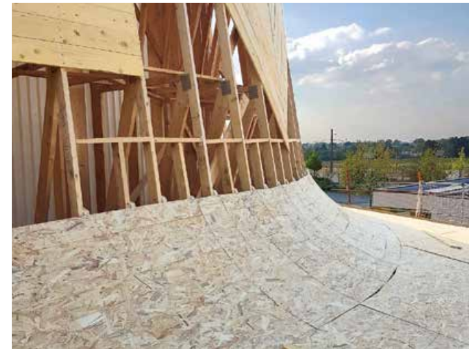
◀ Fachwerkträger und eine Holzschalung bilden die Unterkonstruktion für die Alurauten
