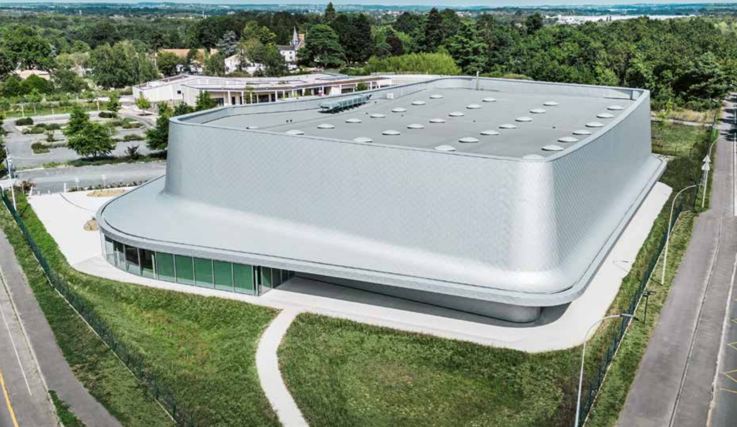
▲ Die Gebäudehülle im Alu-Look dominiert ihr Umfeld und bildet einen visuellen Anziehungs- und Höhepunkt am Ortsrand von Basse-Goulaine
