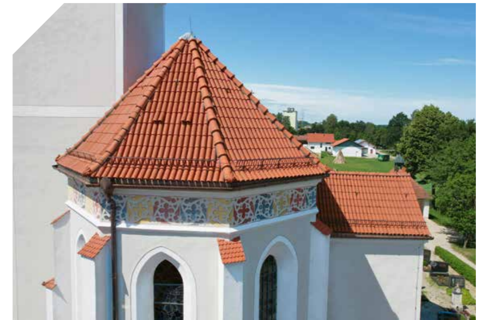
▲ Im Detail: Die zahlreichen Strebpfeiler der Kirche sind mit Biberschwanzziegeln gedeckt
