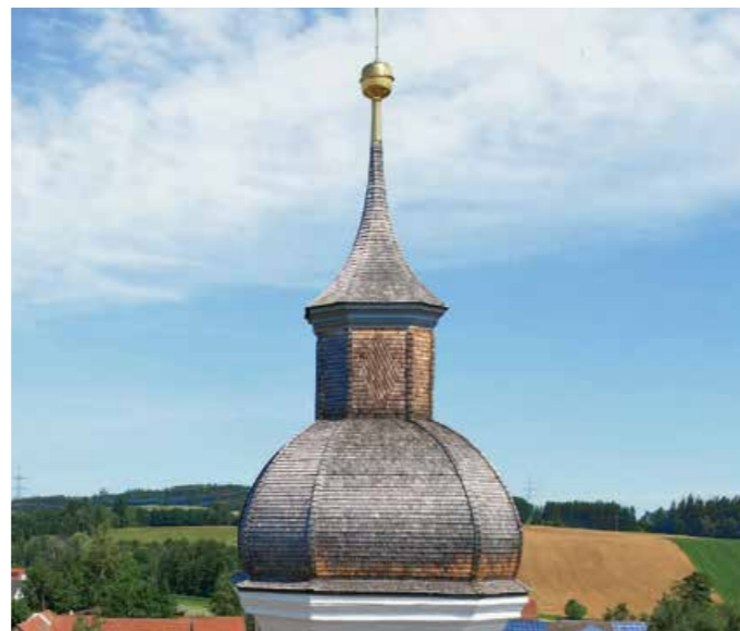
▲ Eine besonderer Wetterschutz: Auf dem Turmhelm befindet sich eine Deckung aus traditionellen Lärchenschindeln
