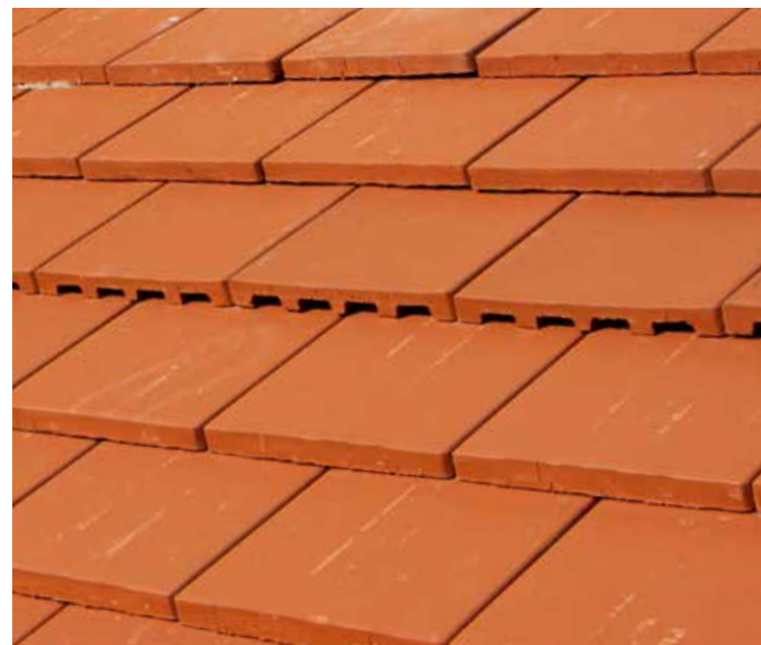
▲ Zeitgemäß: Die beiden Seitendächer aus den 1960er-Jahren wurden mit roten Geradschnittbibern und Rillenlüftern gedeckt
