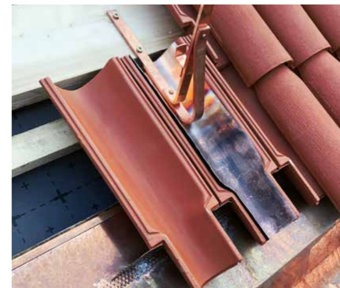
▲ Schneefang: Die Klempner haben in die Nonnen eine Kupferschale aus 1 mm dickem Blech eingeformt. Darauf liegt der Schneefanghaken
