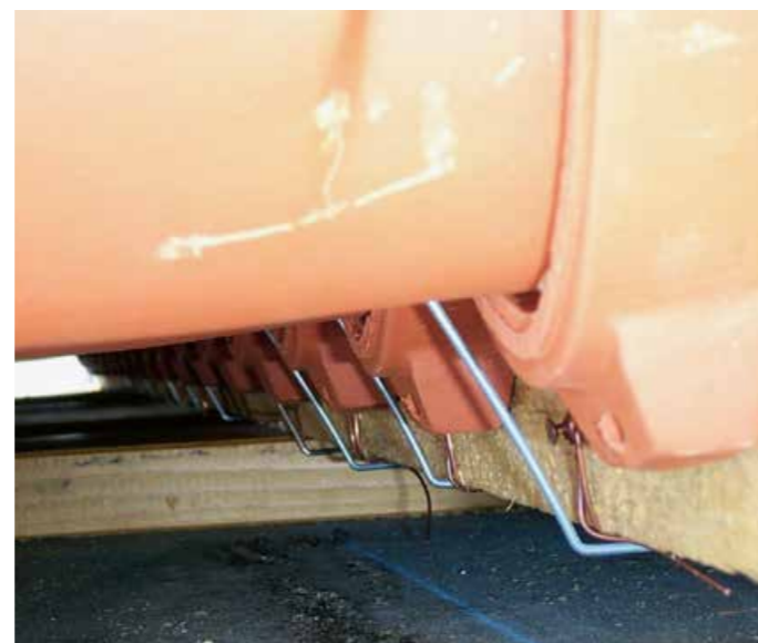
▲ Windsogsicherung: Hier sind die Traufverdrahtung aus Kupfer sowie die Verklammerungen für die Flächenziegel zu sehen
