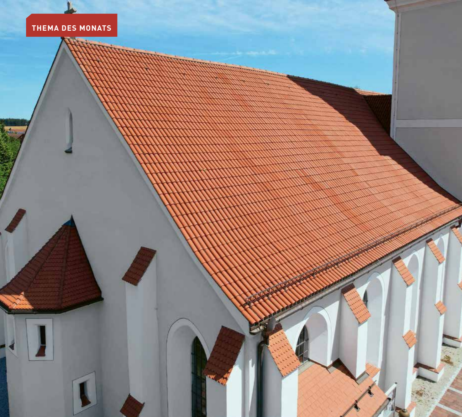
▲ Wunderschöne Dachfläche: Neue Mönche und Nonnen geben dem Hauptdach der Kirche in Baierbach seine ursprüngliche Anmutung zurück
