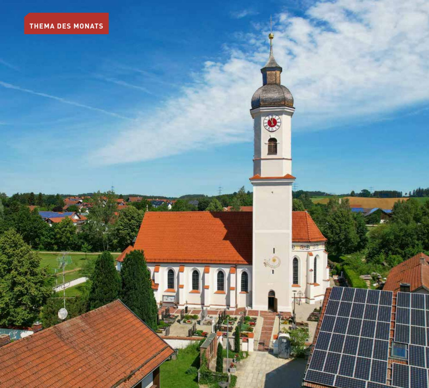
▲ Nachdem im Dachstuhl originale Mönch- und Nonnenziegel aufgetaucht waren, entschied man sich, diese auch wieder als Dachdeckung einzusetzen
