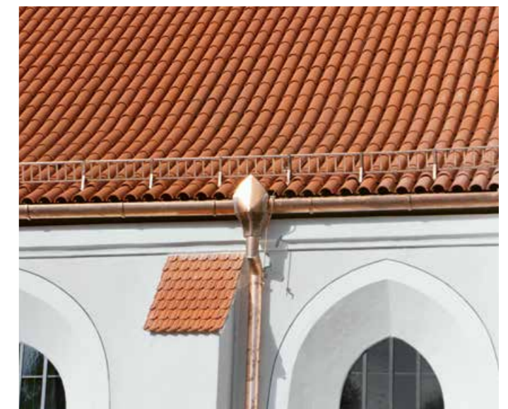
▲ Sicherer Schutz: Der fertige Kupferschneefang mit 12 cm Stuhlhöhe bewahrt Kirchenbesucher zuverlässig vor Dachlawinen
