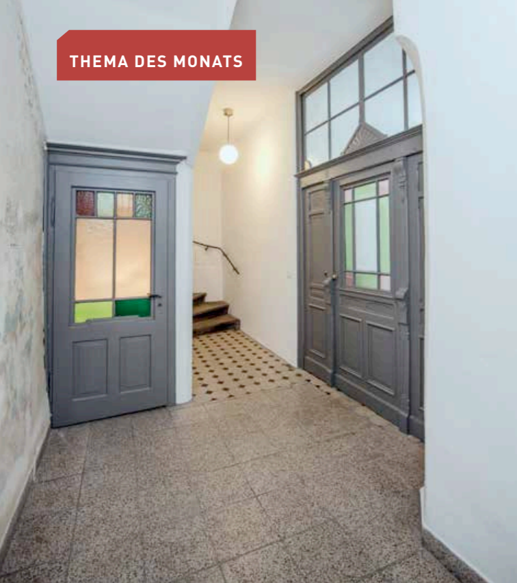
▲ Blick in den sanierten Hausflur: Alle Bauteile wurden hier sorgfältig ...
