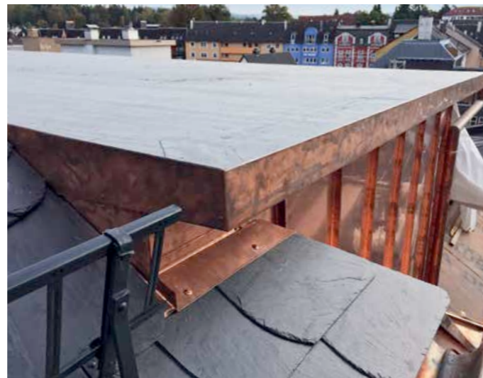
▲ Das Flachdach des Anbaus wurde mit einer Kunststoffbahn abgedichtet
