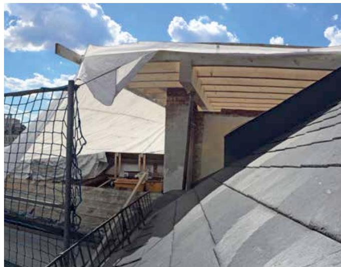
▲ Mehr Platz: Der Anbau im hofseitigen Dach ist eine Holzkonstruktion
