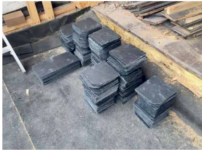
▲ In Marktredwitz wurden zwei verschiedene Schieferformate gedeckt
