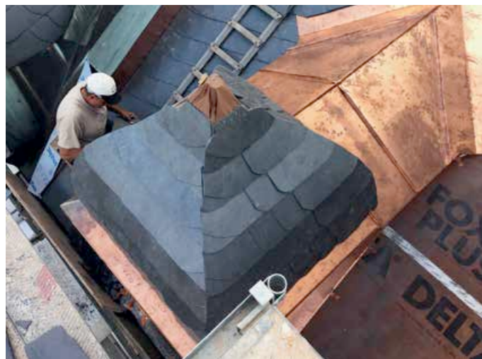
▲ Bei allen Türmen kam das Schieferformat 20x20 cm zum Einsatz
