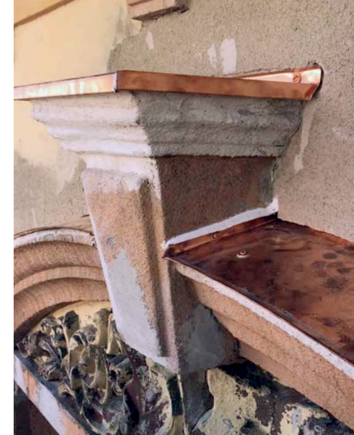
▲ Mauerabdeckung: Alle Blecharbeiten wurden mit Kupfer ausgeführt
