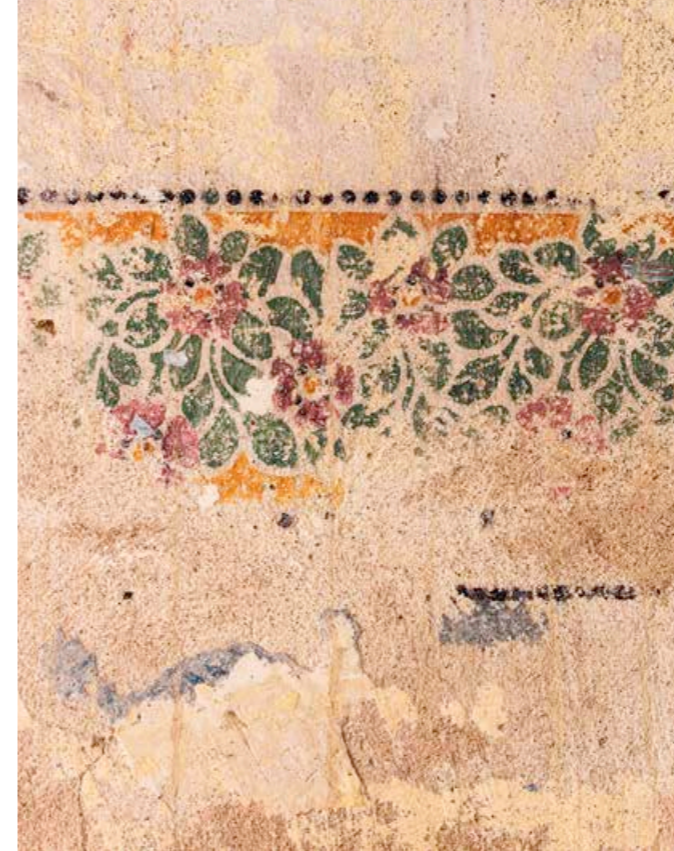
▲ Denkmal von kulturhistorischem Rang: Wandmalerei im Innenbereich
