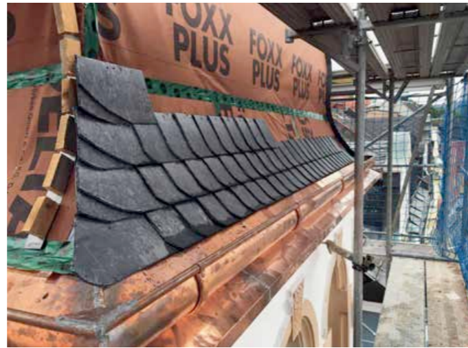
▲ Besonders anspruchsvoll: die neue Schieferdeckung am großen Turm
