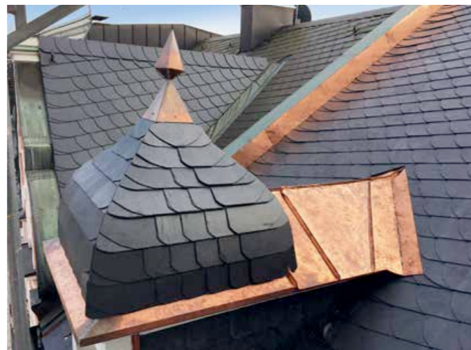
▲ Die fertige Turmdeckung wird von einer kunstvollen Kupferspitze gekrönt
