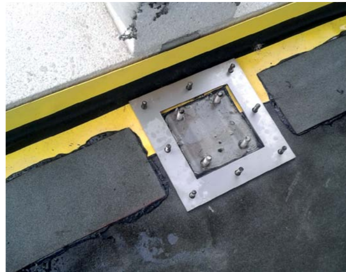
▲ Aussparungen: Die druckbeständigen und verformungsfreien Schaumglasplatten können einfach zugeschnitten werden
