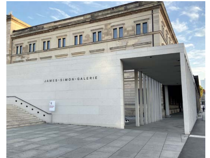
▲ Der homogene Dachaufbau und die robuste Terrassendämmung verhelfen dem Entrée der Museumsinsel zu einer langen Lebensdauer
