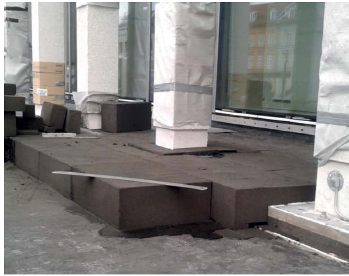
▲ Robustes Kompaktdach: Die Handwerker haben die einzelnen Platten vollflächig und vollfugig mit Heißbitumen verklebt
