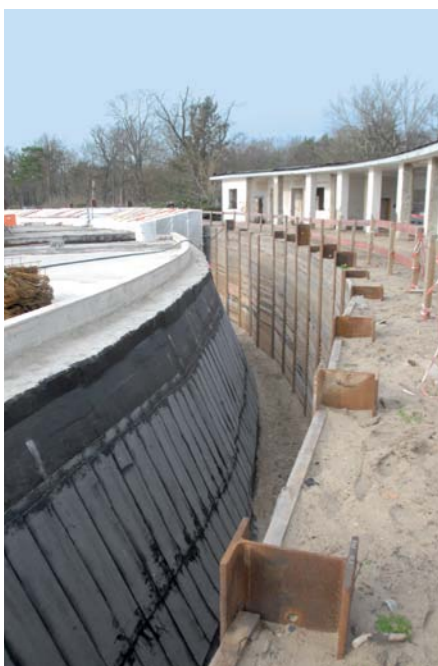
▲ Fertige Bauwerksabdichtung: Im nächsten Arbeitsschritt haben die Handwerker die Baugrube wieder mit Sand aufgefüllt
