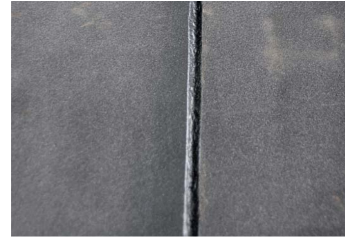
▲ Sauberes Schweißergebnis: Die Überdeckung an den Längs- und Quernähten belief sich stets auf mindestens 8 cm
