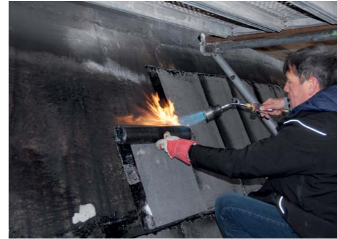
▲ Einlagige Verschweißung der ersten bituminösen Abdichtungslage auf dem mit Bitumenvoranstrich vorbereiteten Untergrund
