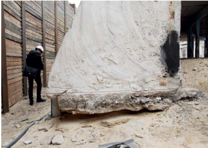
▲ Imposante Konstruktion: Schnitt durch die massive Beton-Rückwand des Terrassengebäudes im Strandbad Müggelsee
