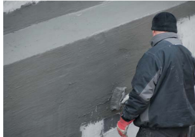
▲ Die Handwerker brachten an der Rückwand zunächst eine Schlämme auf, um den Untergrund für die folgende Abdichtung zu nivellieren
