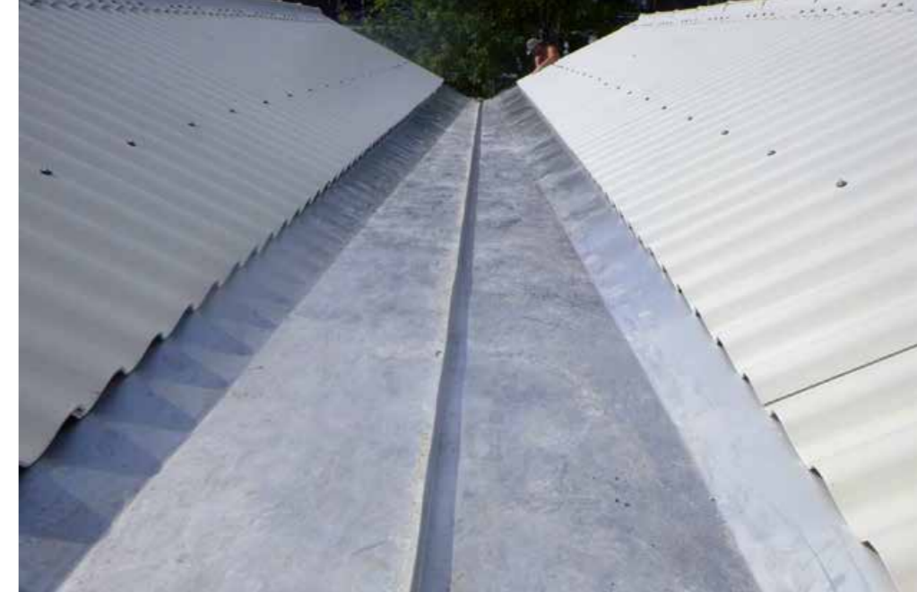
▲ Die neuen Entwässerungsrinnen in den Kehlen wurden in zwei Teilen aus Edelstahl vorgefertigt
