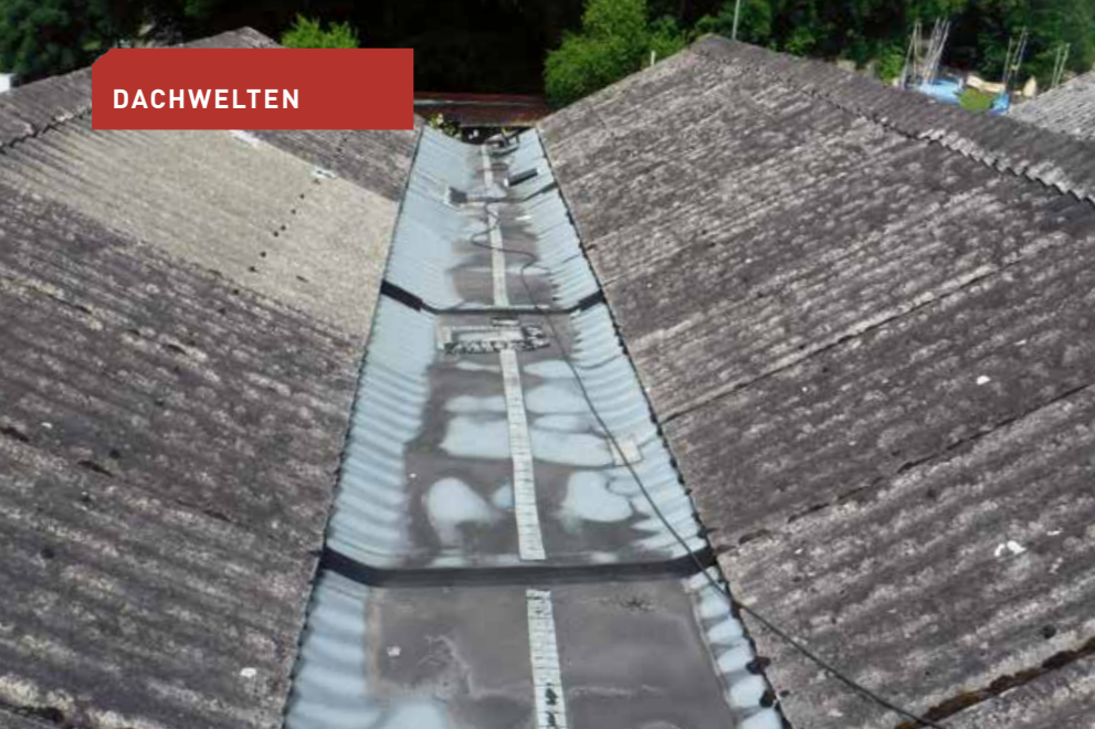
▲ Vor der Sanierung: eine der zahlreichen Kehlen zwischen den kleinen Satteldächern
