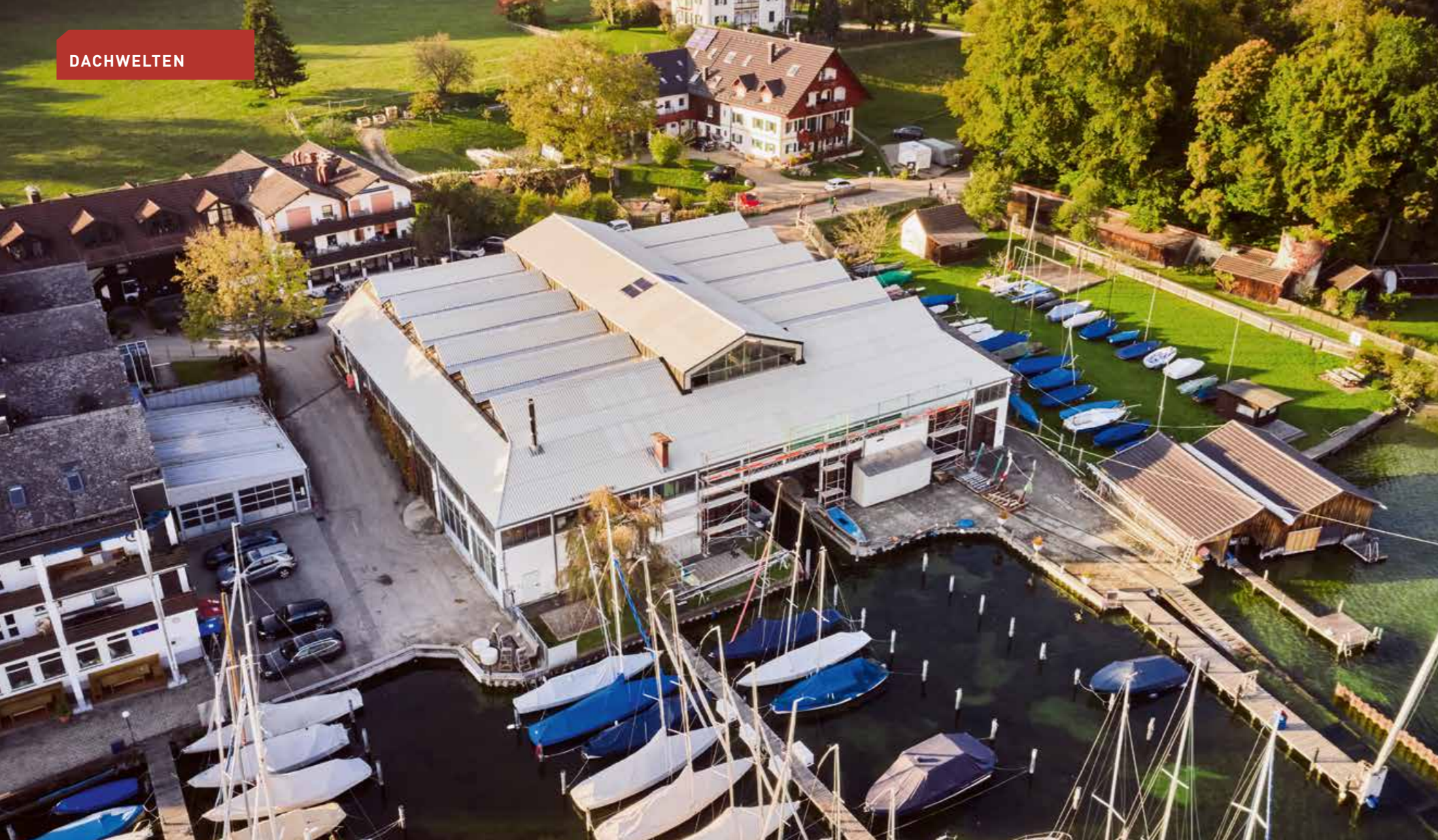
▲ Frisch saniert: Das Dach der Halle der Bootswerft Markus Glas am Sarnberger See wurde mit hellgrauen Wellplatten aus Faserzement neu gedeckt
