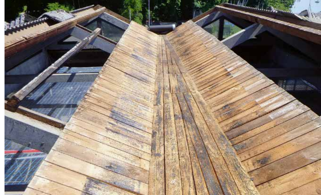
▲ Der Metaldachstuhl nach der Asbestentsorgung: Die alte Holzschalung der Kehle wurde erhalten
