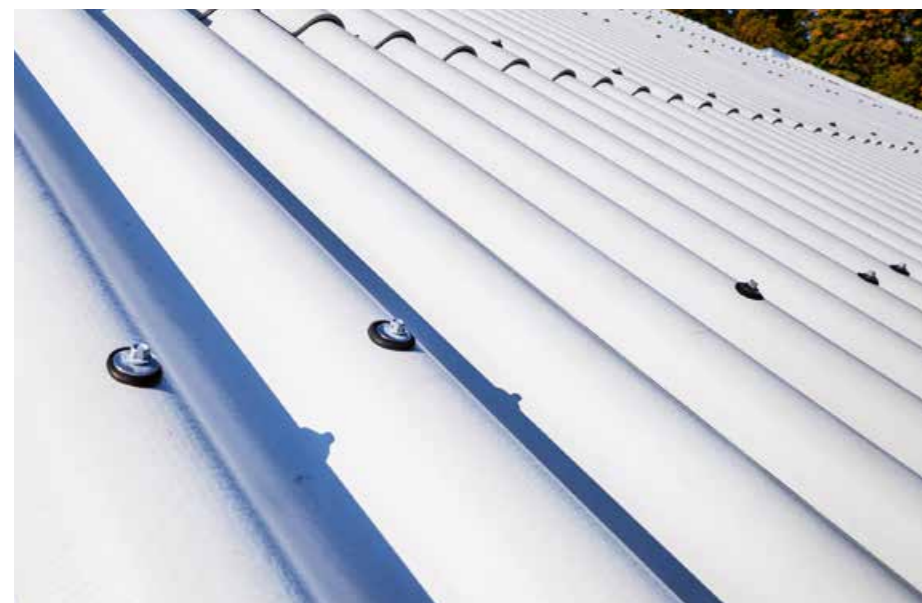
▲ Spezialschrauben mit integrierter Dichtung sorgen für die sichere Befestigung der Wellplatten
