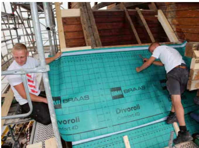
▲ Über der Schalung wurde eine diffusionsoffene Unterdeckbahn verlegt
