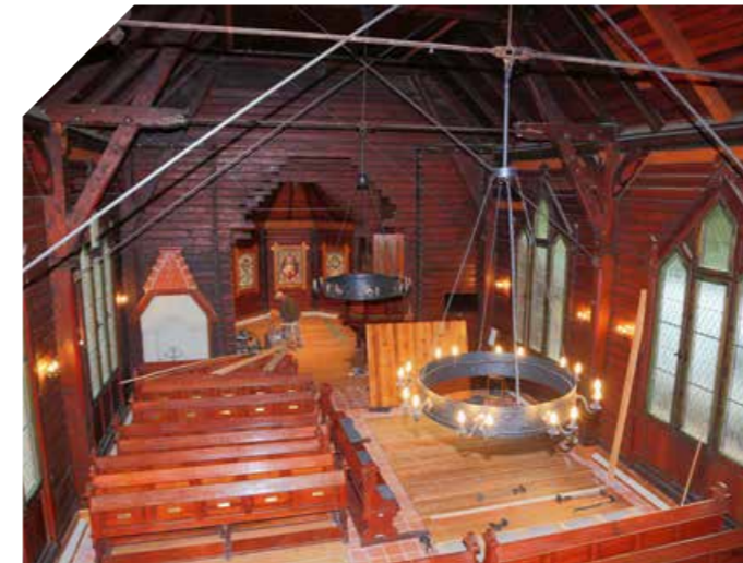
▲ Die Innenwände der Kirche bestehen aus dunkel lasiertem Sichtholz
