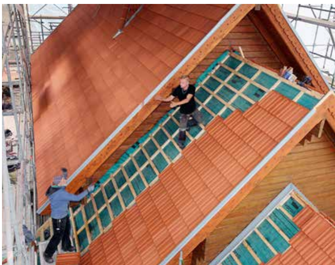
▲ Verlegung der neuen Doppelmuldenfalzziegel auf dem eingehausten Dach
