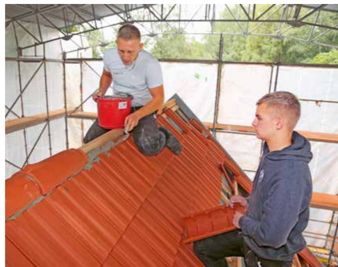
▲ Die Firstziegel wurden nach Vorgabe des Denkmalamtes vermörtelt
