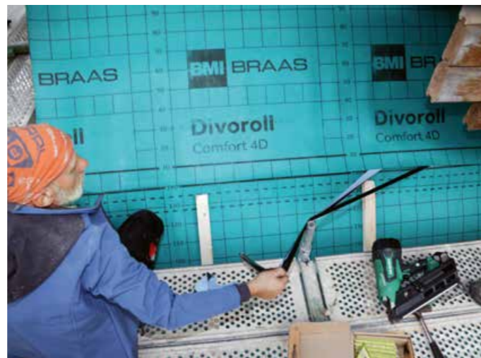
▲ Verklebung: Abziehen der Schutzstreifen im überdeckten Bahnenrand
