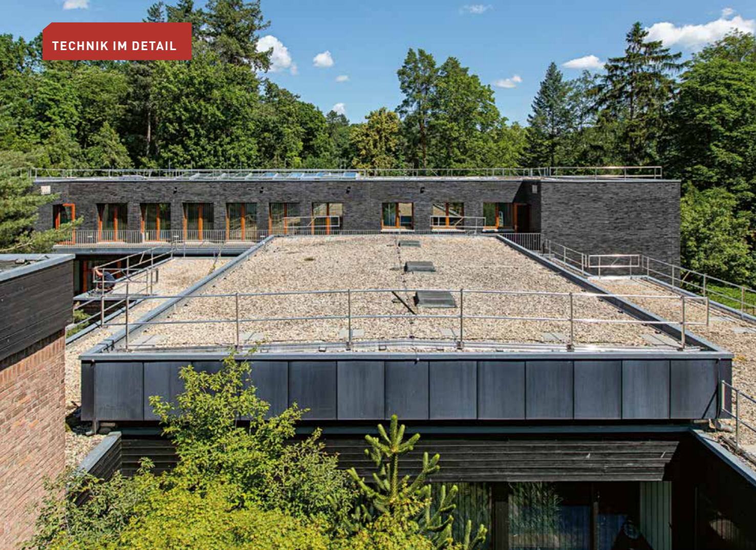
▲ Geländersysteme gelten als ideale Lösung für Flachdächer, bei denen die Schutzvorrichtung möglichst individuell und komfortabel gestaltet werden soll
