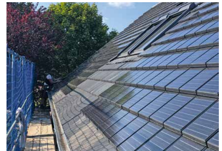
▶ Eine elegante Lösung: Kleinteilige Solardachziegel besetzen eine ästhetische Nische
