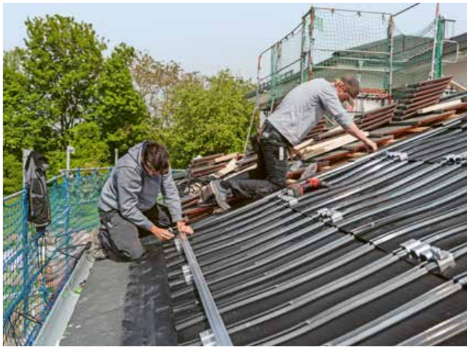
▲ Unter dieser PV-Anlage dient die Intersole als wasserführende Schicht
