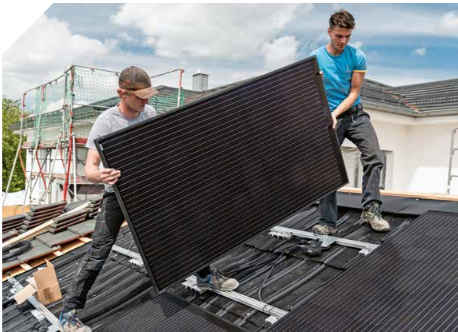
▲ Eine Aufgabe für den Dachdecker: Montage der PV-Module für eine dachintegrierte Solaranlage
