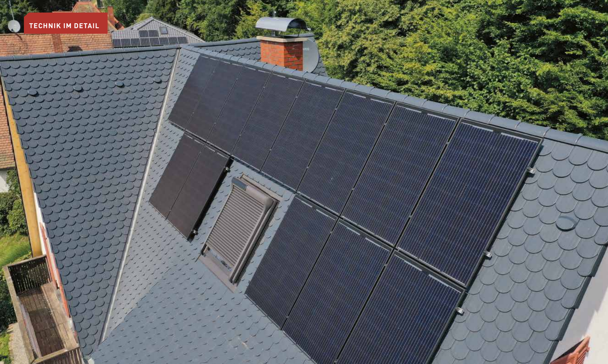
◀ Module auf Biberschwanzziegeln: Aufgeständerte PV-Systeme erfordern eine robuste Statik
