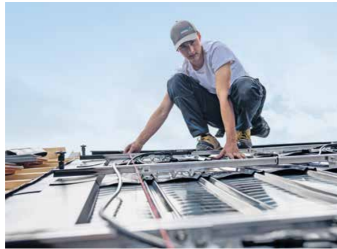
▲ PV-Anlagen, die auf Niederspannung laufen, lassen sich leicht installieren
