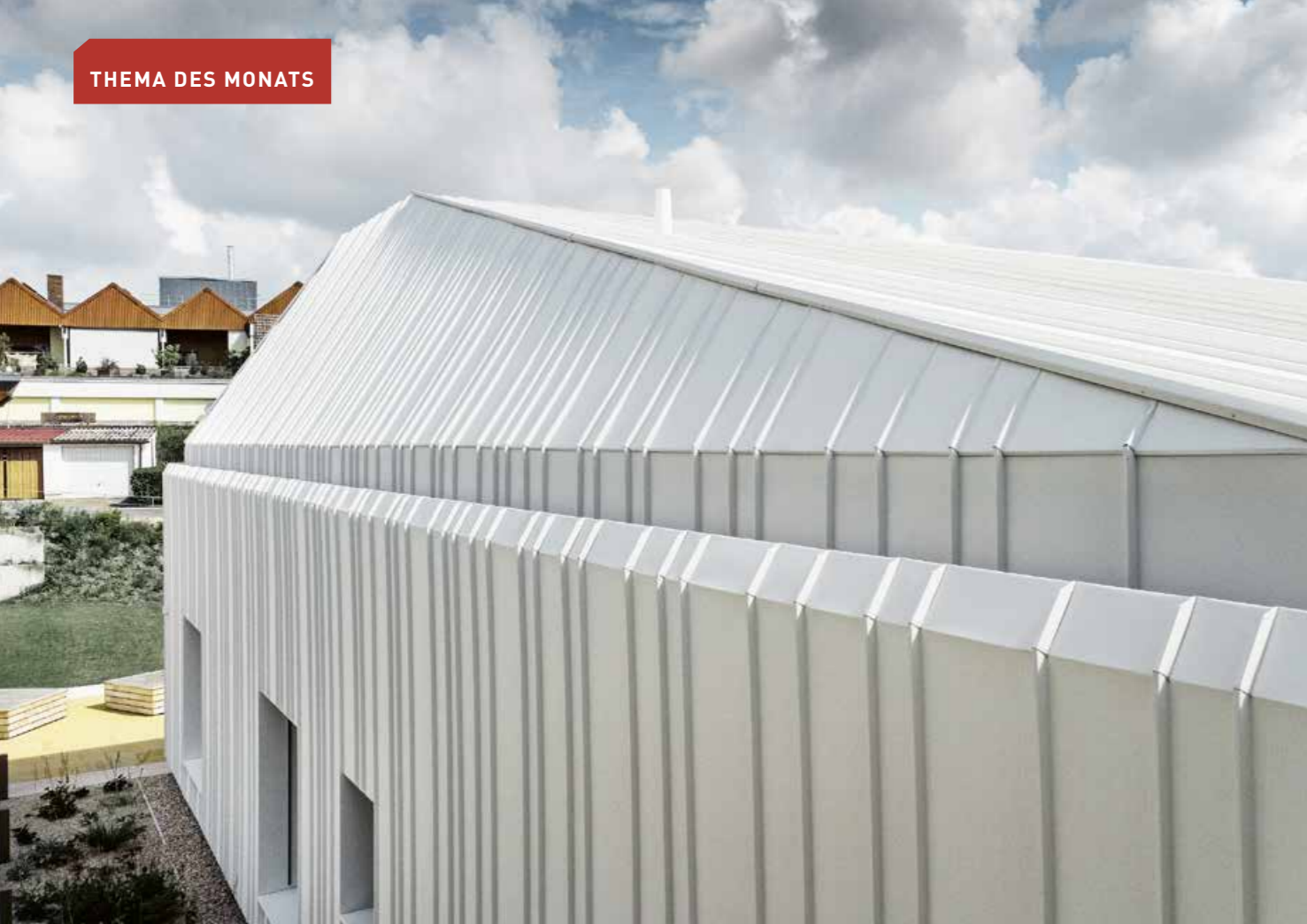
▲ Die charakteristischen Falzlinien rhythmisieren mit drei unterschiedlichen Scharenbreiten die Dach- und Fassadenflächen des neuen Kindergartens
