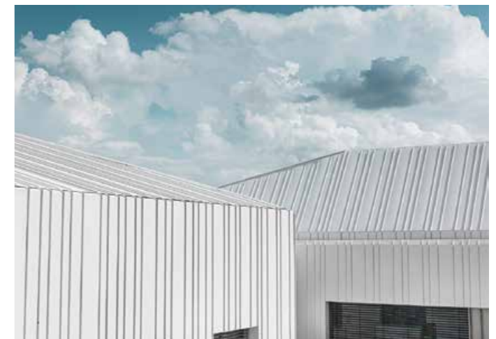
▶ Mit dem Winkelfalz konnten die vertikal durchlaufenden Falzlinien spannungsfrei ausgeführt werden
