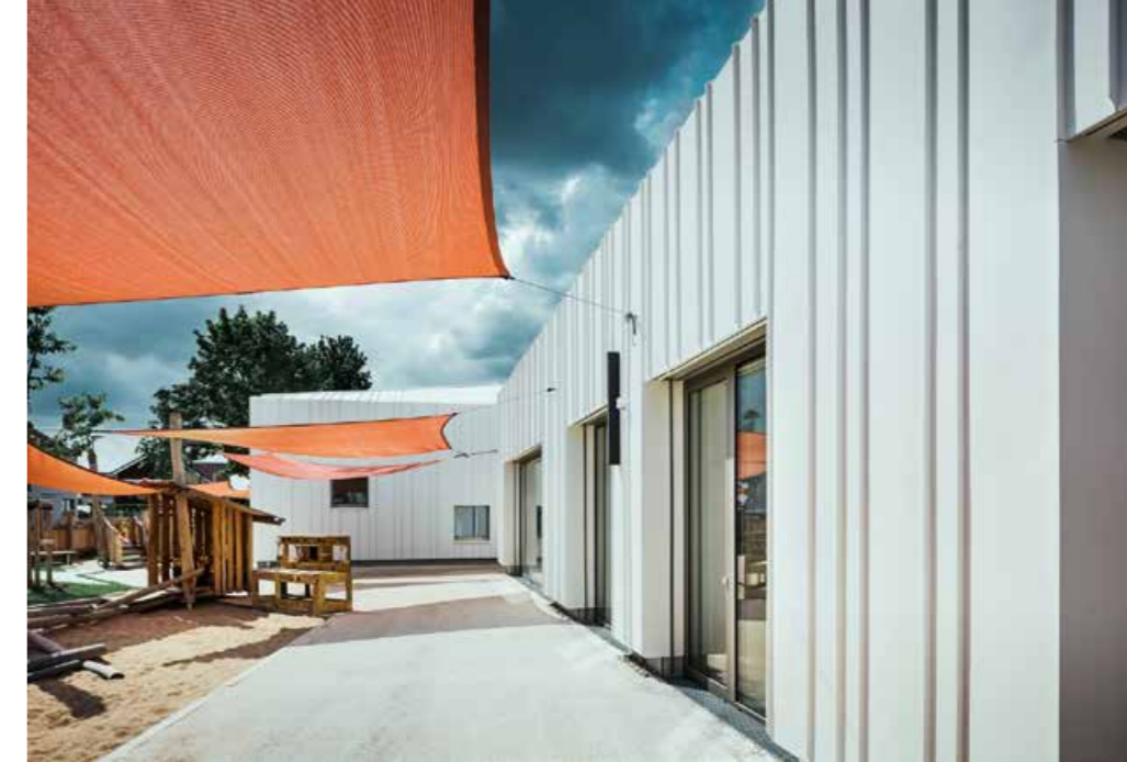
▲ Im Detail: Passschar an den Fensterlaibungen und Einbindung in die Gesamtgestaltung der Fassade
