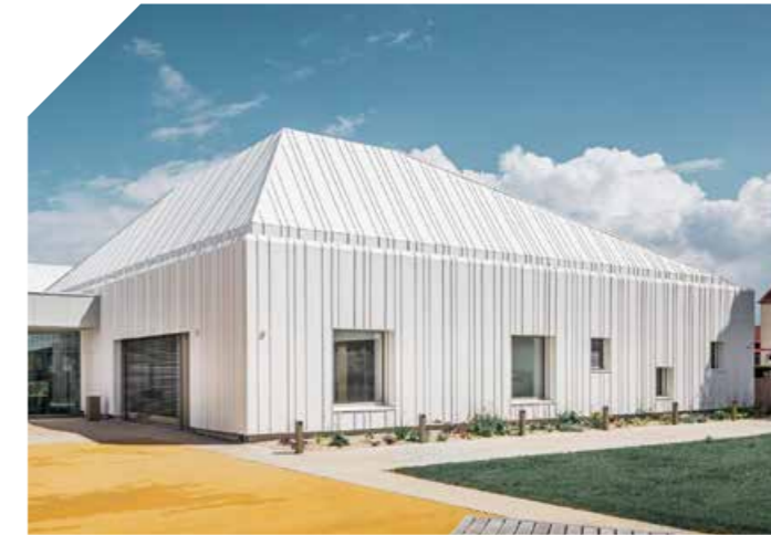
◀ Gut versteckt: Die Oberlichter im First der drei Gebäudeteile sind vom Betrachter nicht zu erkennen
