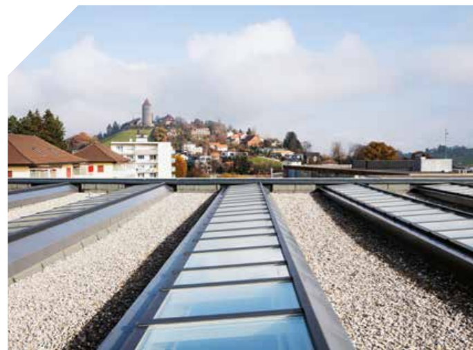
▲ Die 282 Oberlichter wurden als Lichtbänder ins Flachdach integriert
