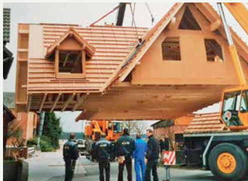
▲ Angekommen: In 10 Minuten ist das Dach am Ziel
