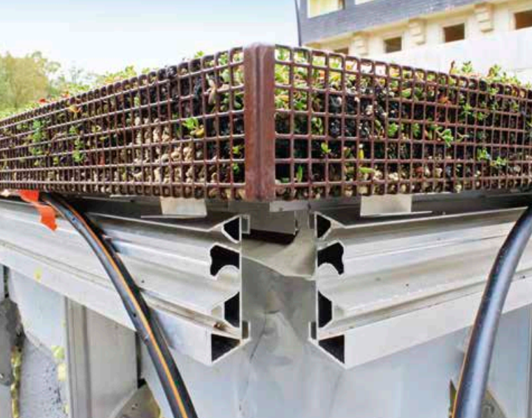
▲ Vorher: Detail am Übergang vom Dach zur Fassade während der Bau-phase. Die Dachbegrünung ist hier bereits komplett verlegt
