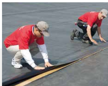
▲ ... und die anschließende Verbindung der beiden Abdichtungsbahnen
