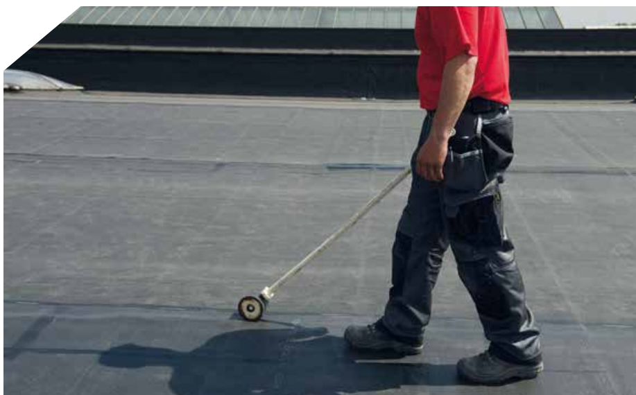
▲ Für eine gute Verbindung: Im letzten Arbeitsschritt kommt die Andrückrolle zum Einsatz
