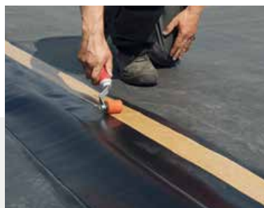
▲ Danach erfolgt das Aufbringen des 76 mm breiten Nahtfügebandes...
