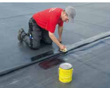
▲ Zunächst wird die EPDM-Bahn mit Primer vorbereitet
