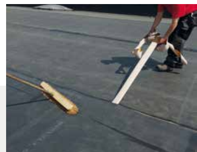
▲ Nach der Überlappung wird das Abdeckband entfernt
