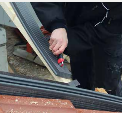
▲ Vor dem eigentlichen Einbau des Dachfensters müssen die Zusatzdämmblöcke zurechtgeschnitten werden
