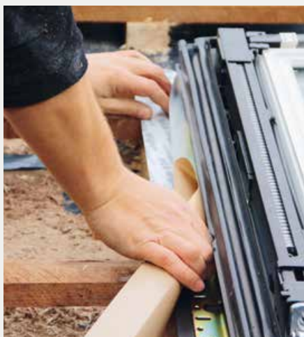
▲ Die Herstellung der Winddichtigkeit erledigen die Handwerker mit dem mitgelieferten Klebeband
