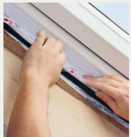
▲ Die Zusatzdämmblöcke werden anschließend sorgfältig und sauber mit dem Folienanschluss verklebt
