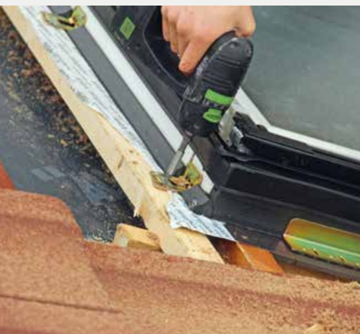
▲ Der nächste Arbeitsschritt ist die Verschraubung des Dachfensters in der Dachlattung
