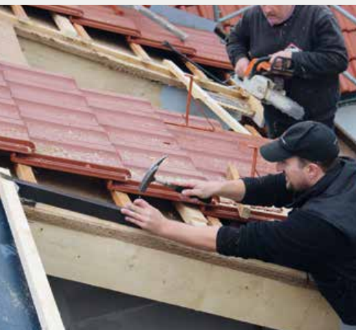
▲ Mit der Montage des Außen-Anschluss-Sets wird die Ausgangssituation für den Einbau des Dachfensters geschaffen
