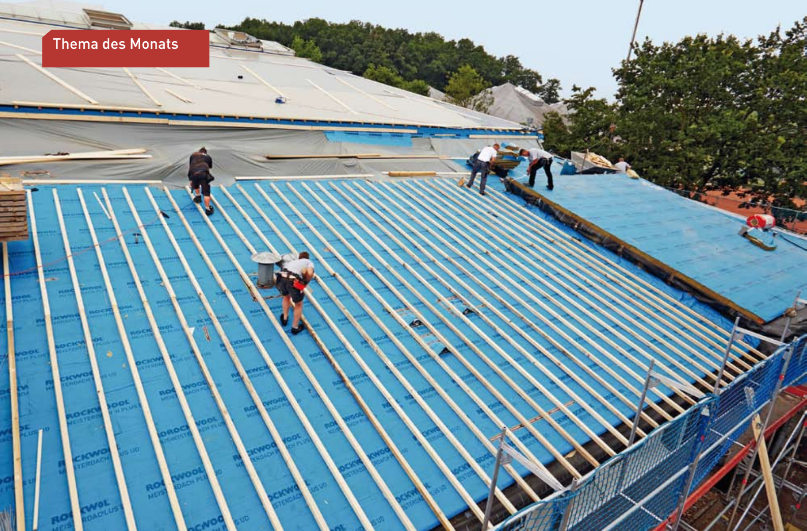
▲ Standhaft: Die Dämmplatten verfügen über eine hohe Druckbelastbarkeit, was die Arbeiten auf dem Dach der Sporthalle deutlich erleichterte
