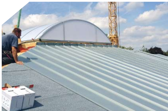
▲ Die Montage der abschließenden Titanzinkdeckung erledigten die Dachdecker in traditioneller Doppelstehfalztechnik
