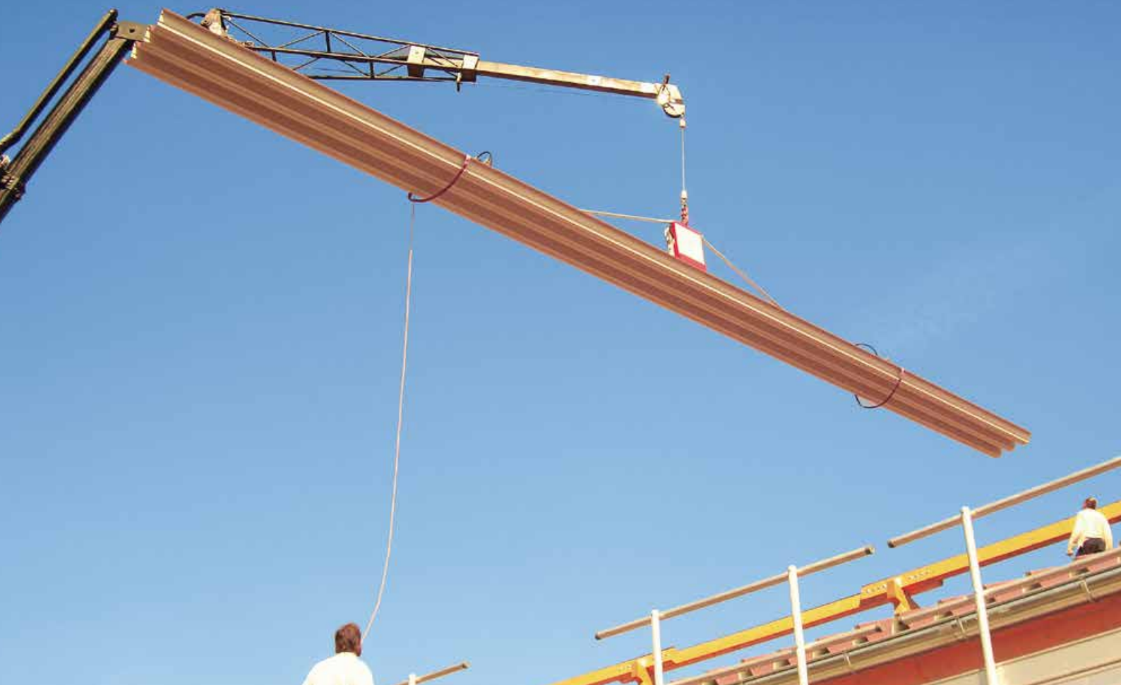
▲ Starke Helfer: Die Vakuumheber Clad-Boy und Clad-Man können bis zu 300 bzw. 800 kg schwere Bauelemente mühelos zum Einsatzort bringen
