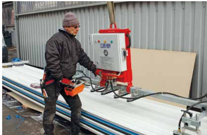
◀ Vakuumheber bieten ein sicheres und schnelles Handling großer Dachelemente
